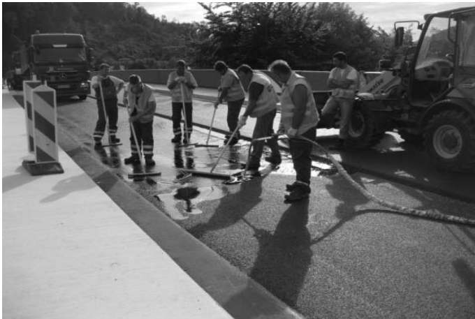
Bild 3: Verfüllen des Traggerüsts mit Gummischiebern – Antoniusbrücke in Meschede
