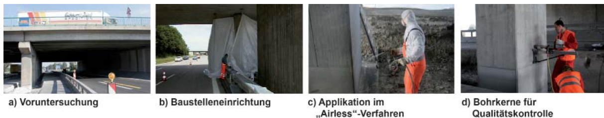
Bild 6: Durchführung einer Tiefenhydrophobierung
