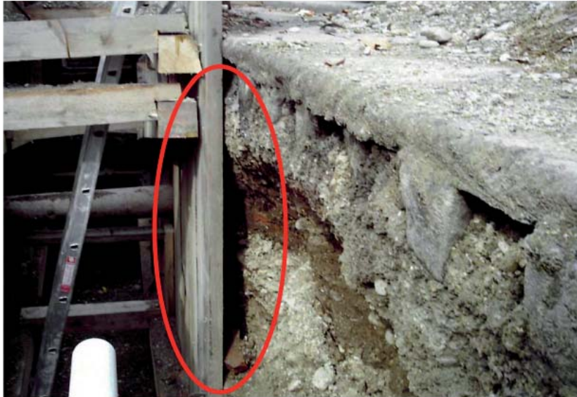
Bild 4: Hohlraum hinter der Baugrubenverkleidung
