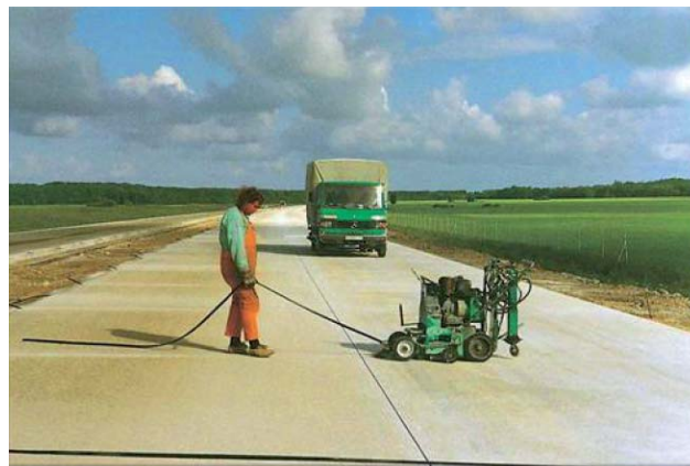
Bild 2: Einbau von Fugenprofilen
