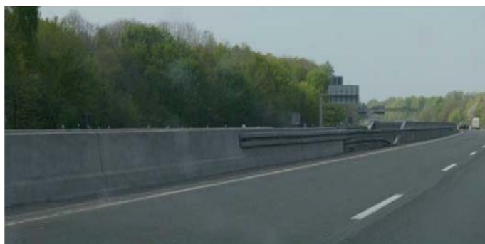
Bild 15: Übergangskonstruktion von Beton auf Stahl
