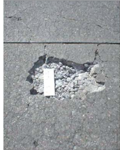
Bild 1 c: Lokale Verschotterung
