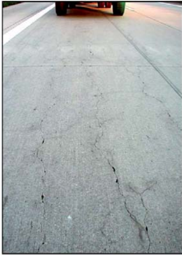
Bild 1 a: Längsrisse
