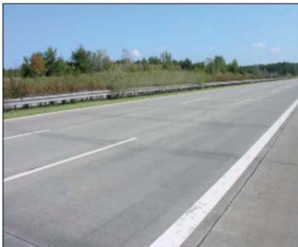
Bild 7: Dunkelfärbungen im Fugenbereich als mögliches Indiz einer beginnenden AKR [8]
