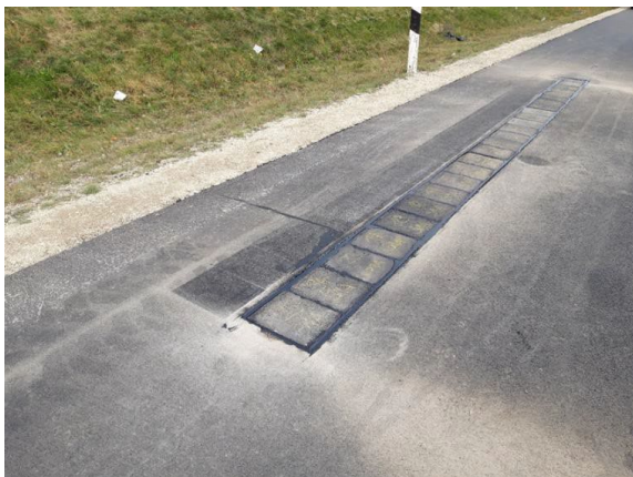
Bild 1: Einbau der Asphalt-Probeplatten in Versuchsfeld auf der B 17 Richtung Landsberg am Lech auf Höhe der AS Klosterlechfeld
